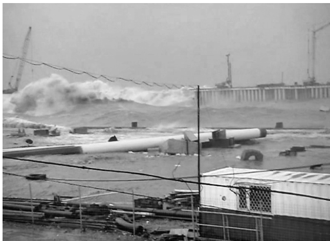
Рис. 7. Фото шторма в грузовом порту Сочи 14 декабря 2009. Штормовые волны сквозь разрушенный волнолом проникают на акваторию порта.
